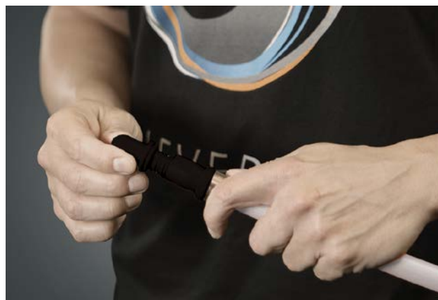
Introducerea fittingului
