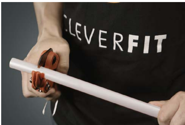
Tăierea corectă a conductei cu o foarfecă
